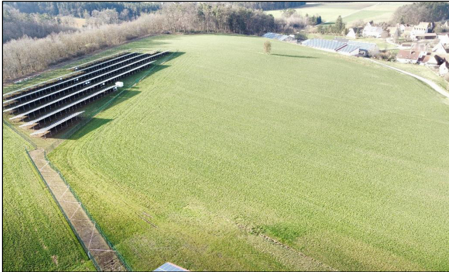
Abbildung 4: Sicht von Nordost nach Südwest
